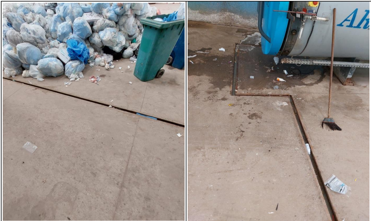
Figura 19 – RSS – Canaleta de Coleta de Chorume
