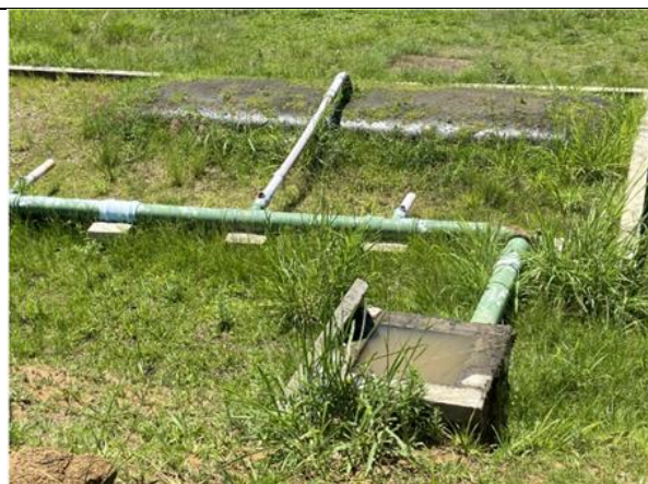
Figura 77: Vista das geobags de desidratção de lodo da ETA Jaconé.
