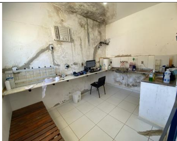
Figura 75: Vista do laboratório da ETA Jaconé.
