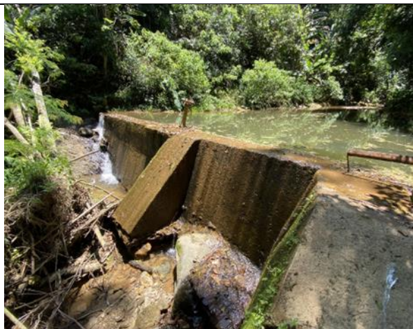
Figura 78: Vista da Barragem na Serra do Pinheiros – Captação de Sampaio Correia.
