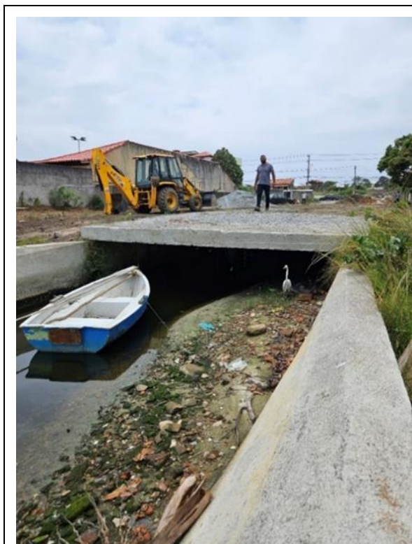
Figura 91: Obras de drenagem executadas em Turfa (ref.: dez./2023).
