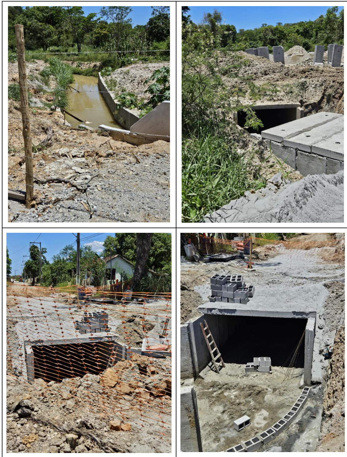
Figura 103: Fotos da instalação das galerias nas Rua Melchiades (ref.: dez/2023).
