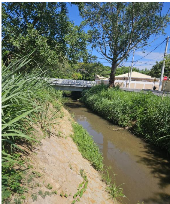
Figura 95: Construção de Ponte em Verde Vale (ref.: jan/24).
