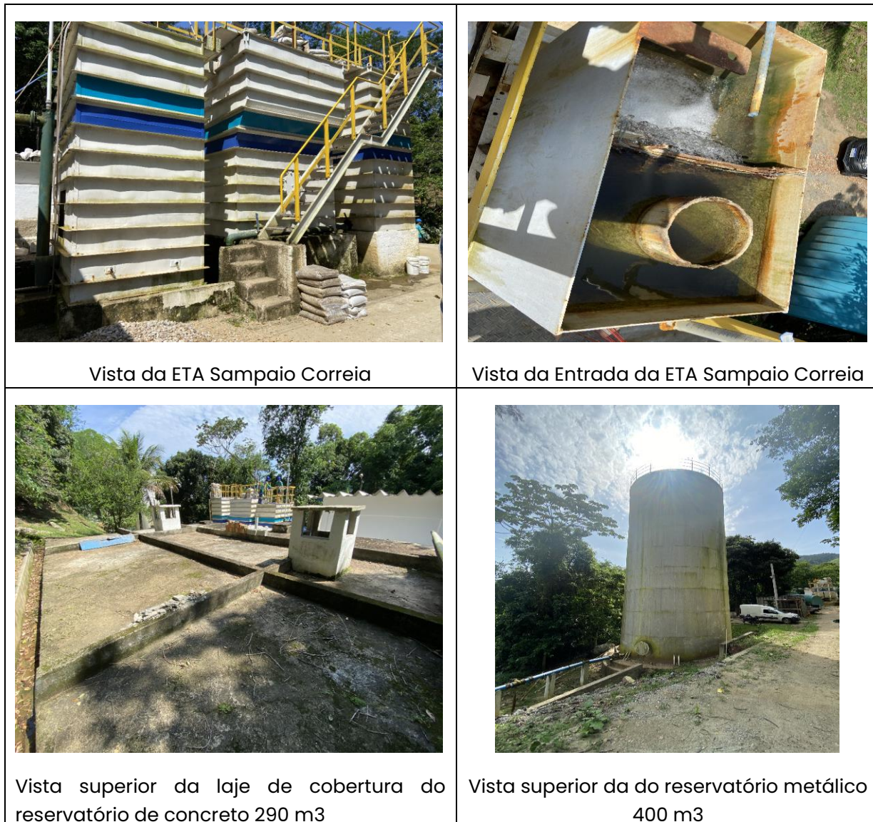
Figura 83: Fotos da ETA Sampaio Correia.
