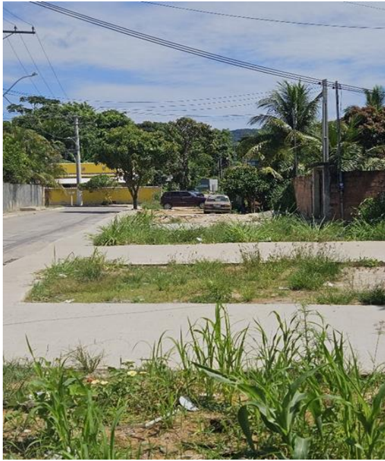
Figura 93: Galeria executada ao longo da R. Fabio Lucio dos Santos, cidade da Saúde.
