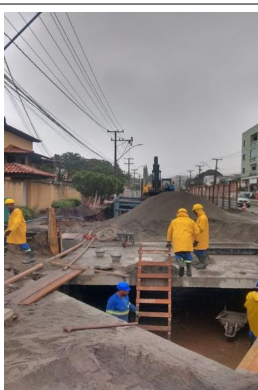
Figura 92: Durante a construção na Av. Saquarema (Fotos de Acervo).
