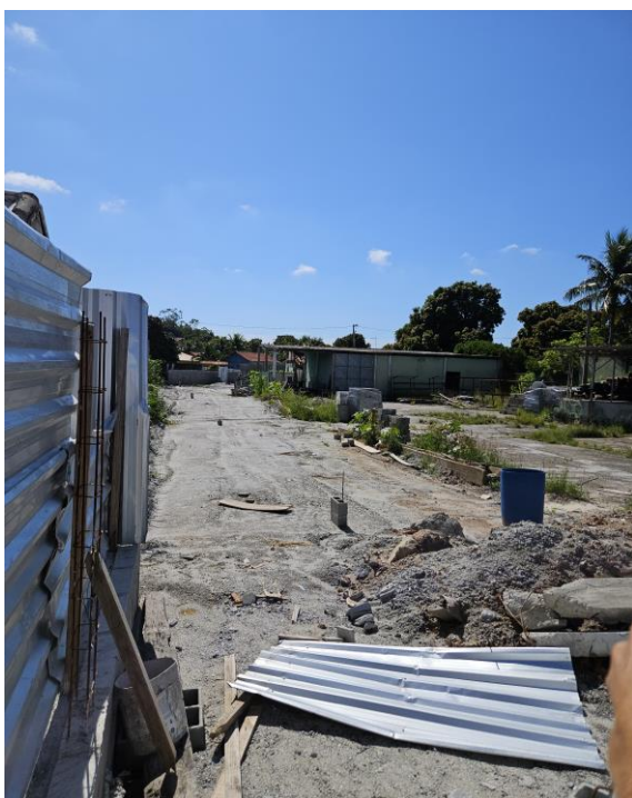
Figura 97: Obras de drenagem executadas travessia de galeria na Av. Saquarema (ref.: jan/24).
