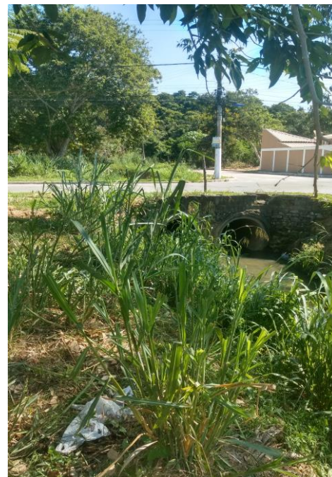
Figura 96: Foto do acervo, galeria sob a via estrangulando a calho do rio Bacaxá.
