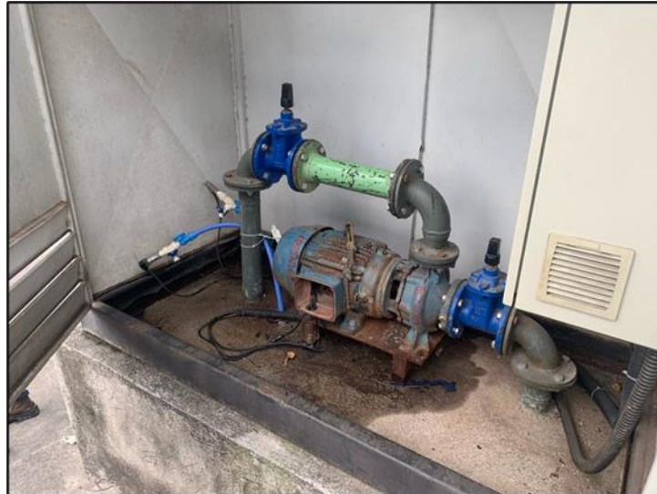
Figura 52: Booster DPO (Bacaxá).
