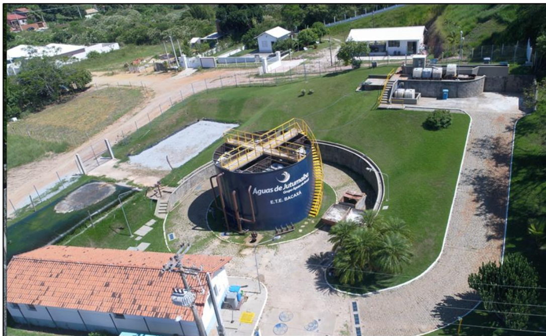
Figura 21: Vista da ETE Bacaxá.
