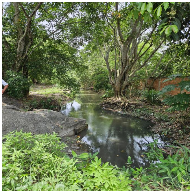
Figura 99: Canal de Desague da galeria na rua das Tocas (dez/2023).
