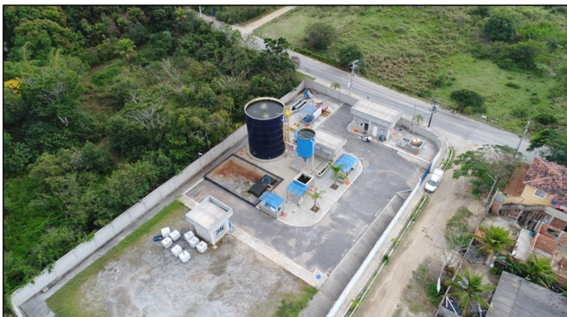
Figura 25: Vista da ETE I Jacarepiá.
