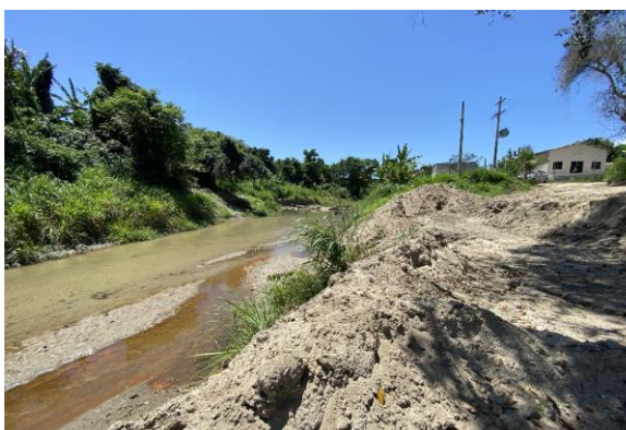
Figura 68: Vista do Rio Roncador a montante da captação de Jacaré.
