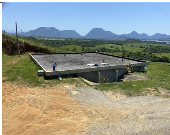
Figura 72: Vista superior do Reservatório Jaconé.
