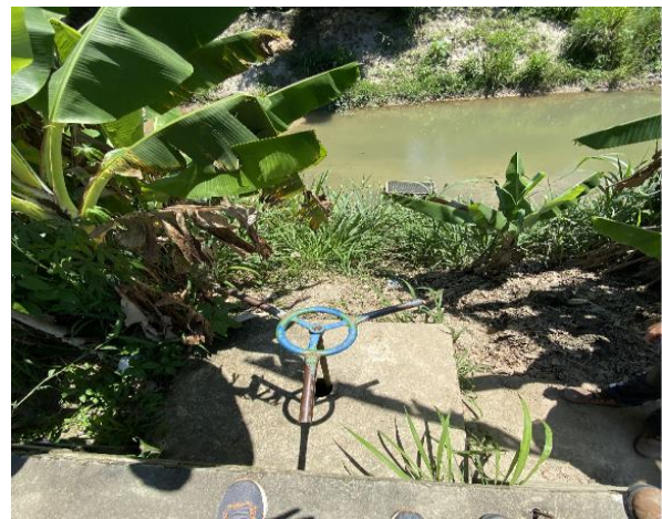
Figura 62: Vista da Tomada D'água no Rio Roncador.
