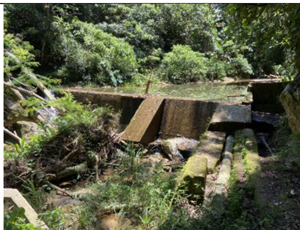
Figura 81: Vista da Barragem na Serra do Pinheiros – Captação de Sampaio Correia.
