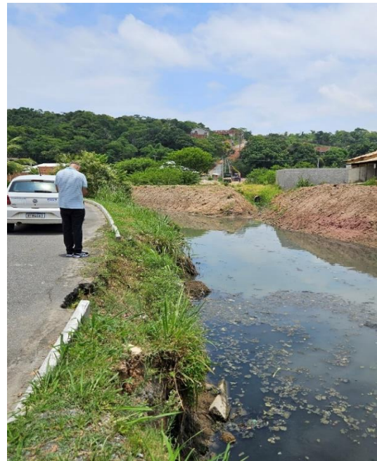
Figura 118: Tomada Bacaxá - vista de montante para Jusante.
