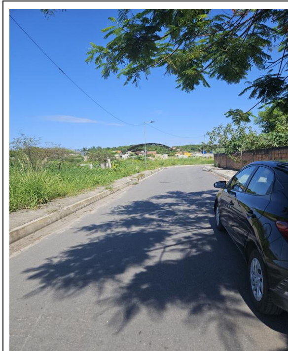
Figura 100: Obras de drenagem executadas rua João Santana (ref.: jan/2024).
