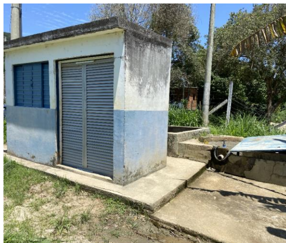
Figura 66: Vista Geral da Elevatória de Água Bruta.
